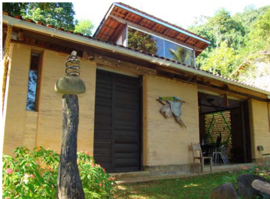
Casa construída pelos arquitetos Márcia Macul e Sergio Prado utilizando apenas as técnicas de sustentabilidade, paredes em taipa, feita com a própria terra do local. O custo representa 2/3 de uma obra tradicional.
